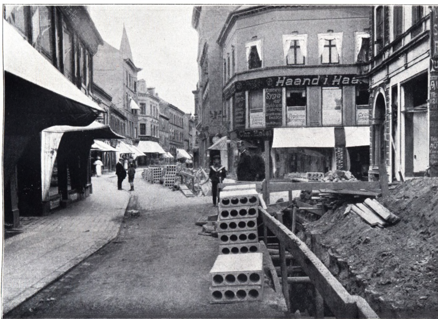
22. Nedlæggelse af Cementblokke i Vestergade.
