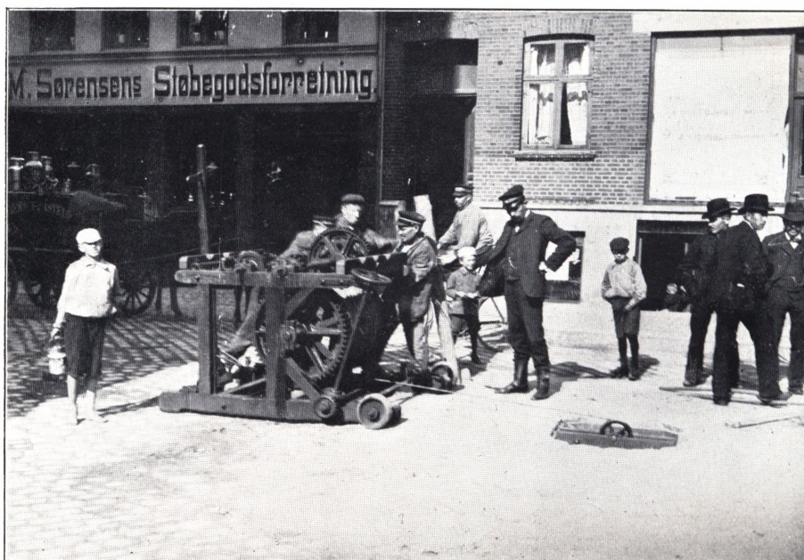
23. Indhaling af Kabler, Spillet.
