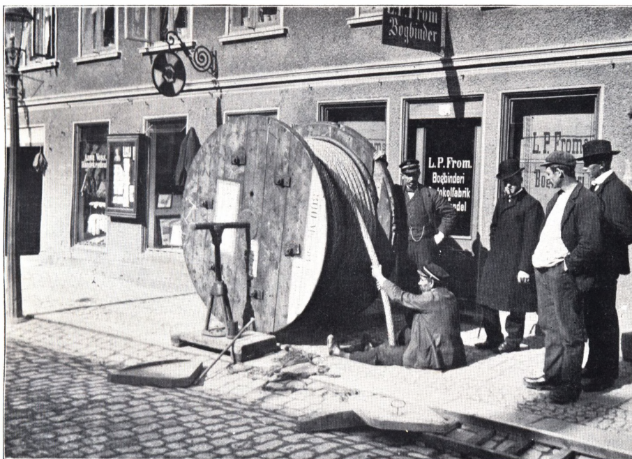
24. Indhaling af Kabler, Tromlen.
