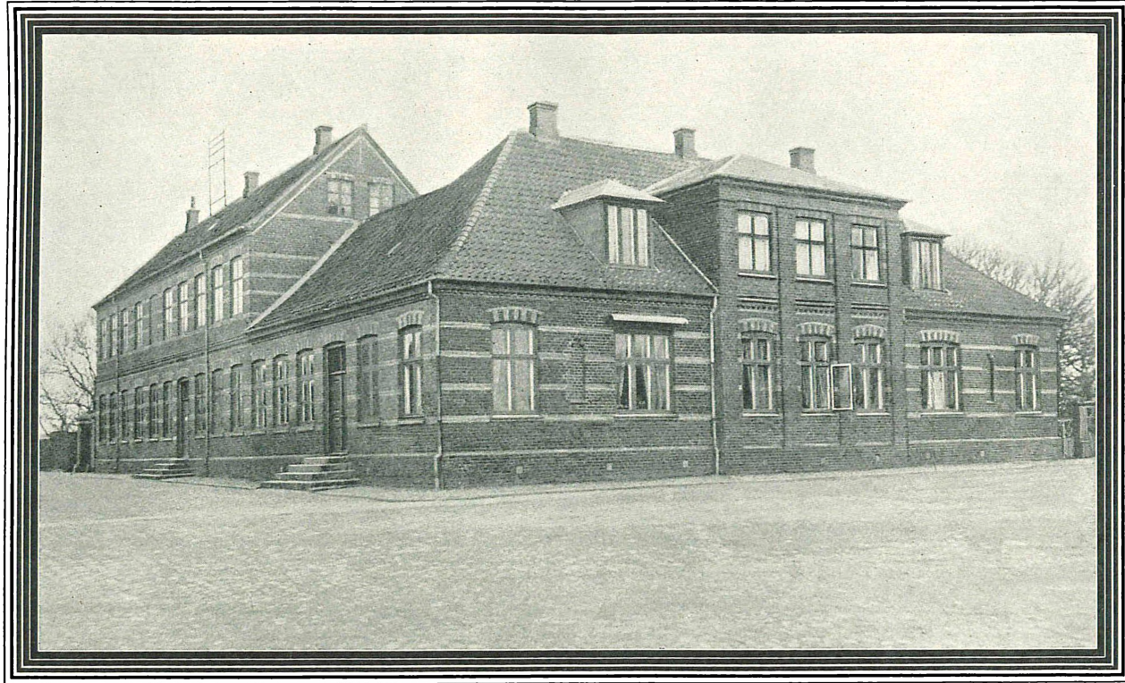
DEN GAMLE KONTORBYGNING OG DIREKTØRBOLIG
