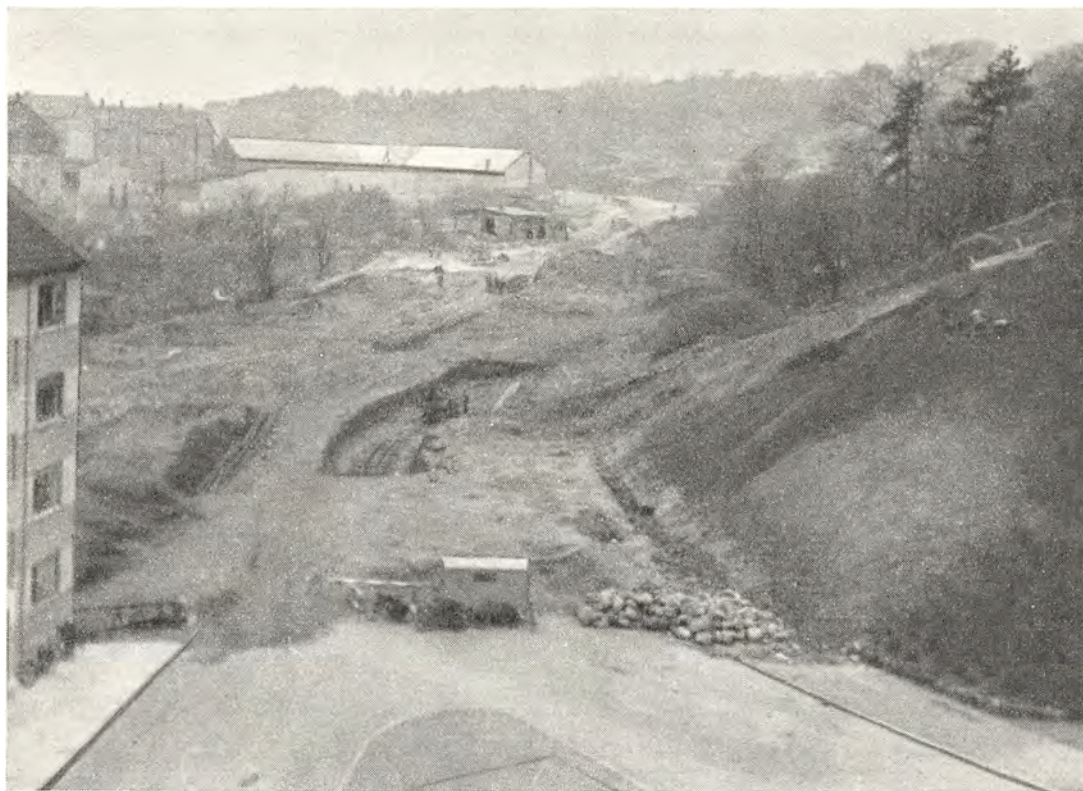
Sjællandsgade under anlæg i 1941.
