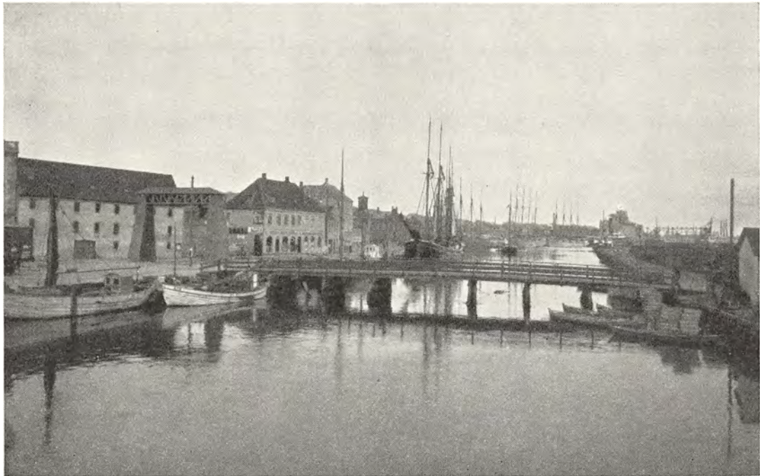
Den gamle havn, forbindelsesbroen mellem nordsiden og Kulholmen.
