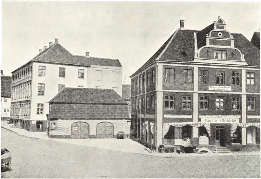
Lauritz Blichfeldts ejendom paa torvets nordside med byens sprøjtehus til venstre, begge bygninger nedbrudt 1905 ved opførelse af Handelsbankens bygning.
