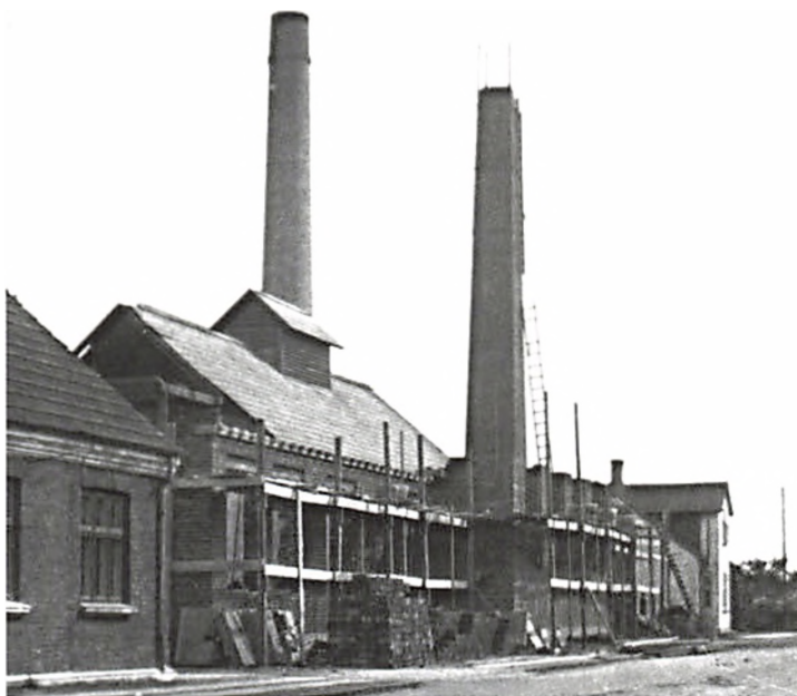
Billede 3. Nedrivning af gammel mejeriskorsten. 1930.
