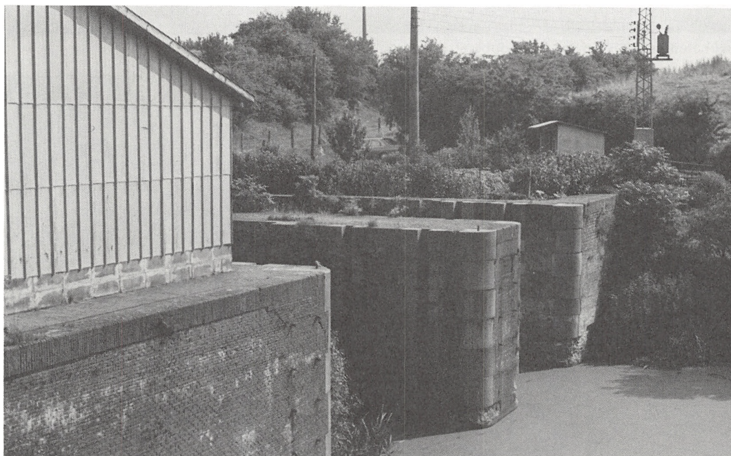
Slusekammer ved Rendsborg. Billedet er taget på det sted, hvor Ejderkanalen blev ledt ind i Ejderen. (Foto: Th. Peters).
