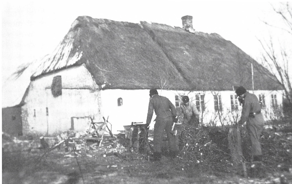
Arbejde på LAT/2 i Rejsby. Foto: Frants Jensen.
