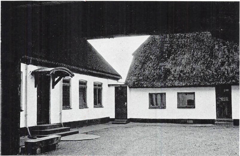
Højbjerggårds stuehus og gårdsplads, fotograferet 1962.
