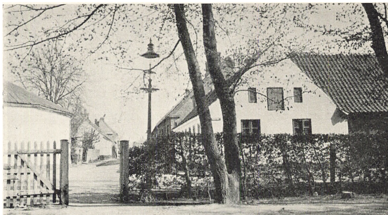
Vestligste Del af Storegade ca. 1910. I Forgrunden Laagen ind til „det nye Anlæg“, til venstre Bryggeriets Iskælder, til højre Peder Grunds Hus.
