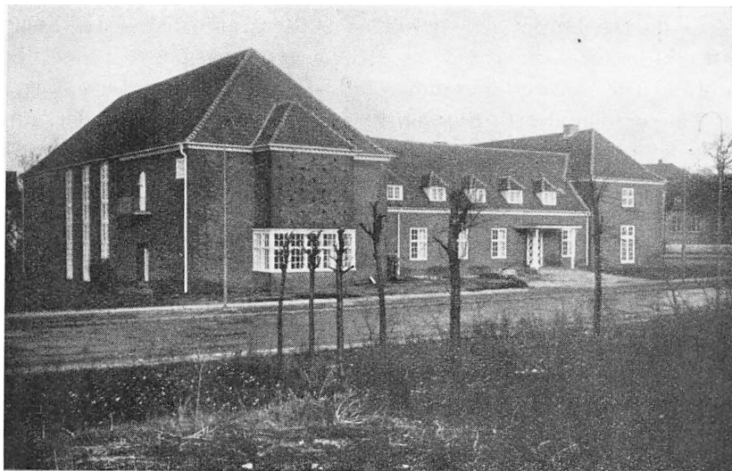
Det nye »Tønderhus«.
