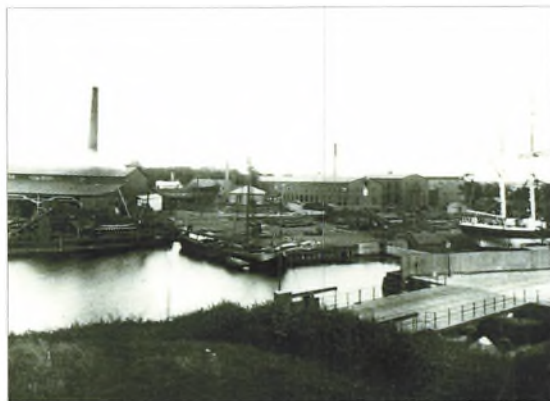
Helsingør Jernskibsværft omkring 1890 set fra Kronborgs volde. I baggrunden ses Træskibsværftet klemmt inde mellem Jernskibsværftets bygninger.
