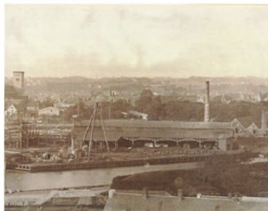
Udsigt over den store skibsbygningshal med den trebenede dampkran og pladelageret. I baggrunden Jernskibsværftets tidligste bygninger.
