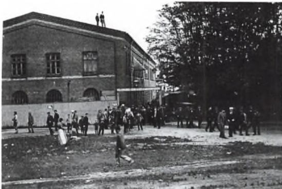
Indgangsporten til Helsingør Jernskibs- og Maskinbyggeri i Allégade omkring 1890. Bygningen rummede kontorer og forskellige værksteder. Den blev genopbygget efter en brand i 1932.
