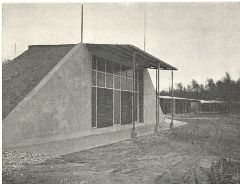
Fig. 47. Moderne blandingshus og magasiner for røgsvagt krudt, bygget med let tag og forside. 1958
