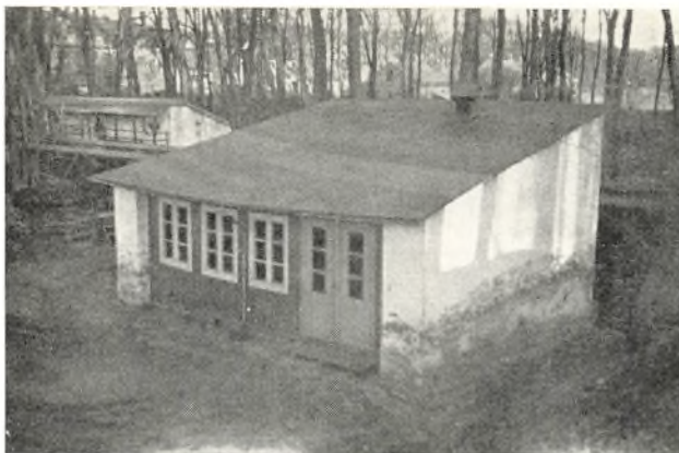
Fig. 35. Champy'sk rundkorningsmølle med let tag og forvæg og med svære bag- og sidemure. Opført 1879
