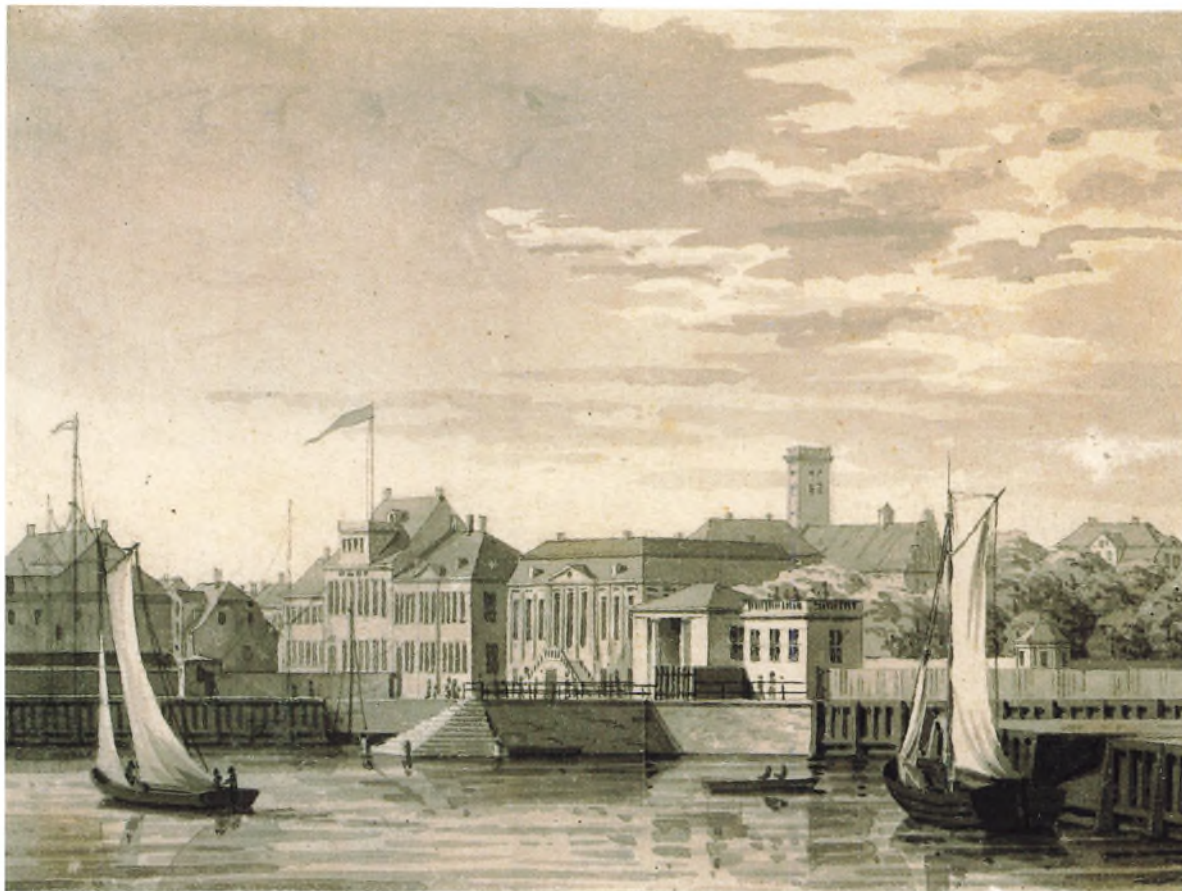
Denne akvarel er ganske vist udført i 1830'erne, men næppe meget var forandret i Hildegard Råzgas barndom. Midt i billedet ses Øresunds Toldkammer, der havde sin egen landingsbro i havnen. Det er den, man ser med trapperne. Ved broen var opført de to viste småbygninger, nemlig brokapernes vagthus og karantænehuset. Til venstre i billedet ses Strandgade 90 og 92.
