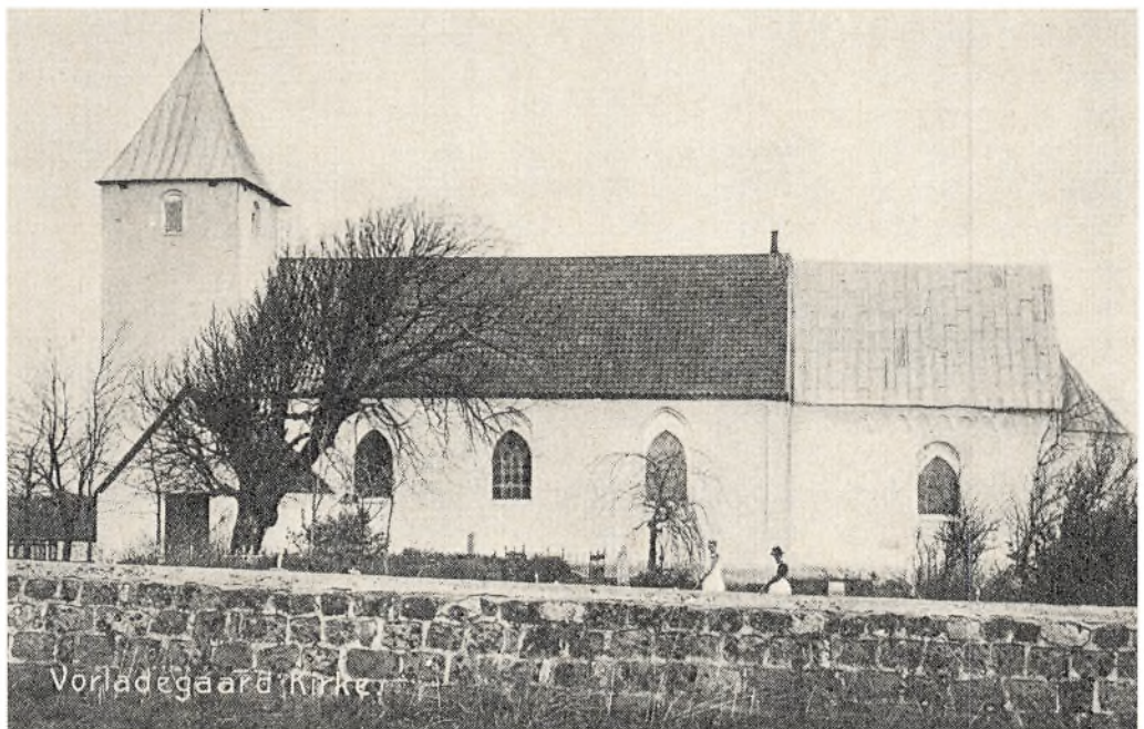
Voerladegård kirke, Tyrsting herred, set fra syd. Den store hvidkalkede kirkes ældste del består af absis, kor og skib fra romansk tid, overvejende bygget af frådsten med en del rå kamp og al. Kor og skib har under gesimserne en rundbuefrise. I sengotisk tid er der over skibets sydvestlige hjørne bygget et tårn i skibets halve bredde, således at den sydlige halvdel af skibets oprindelige vestmur indgår i tårnets vestmur. Våbenhuset mod syd er opført af munkesten i krydsskifte og er antagelig fra begyndelsen af 1600-årene. Postkort fra 1907. Statsbiblioteket, Århus.
