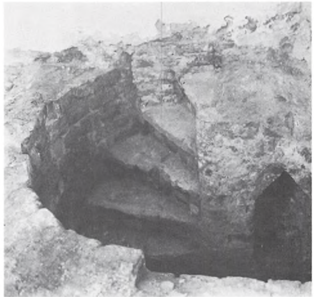
Fig. 23. Stengade 72. Vindeltrappe mellem kælder og stueetage indbygget i forhusets bagmur mod sidebygningen – formentlig i sidste fjerdedel af 1500-årene. Fot i Helsingør Bymuseum.
