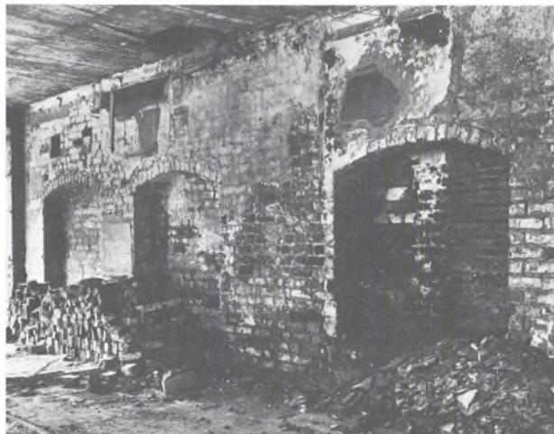
Fig. 27. Stengade 74. Stueetagens østmur med de fire fladbuede spareblændinger. Herover anes i billedets venstre side fire delvis tilmurede bjælkehuller fra det oprindelige bjælkelag. Hugo Matthiessen fot 1933 i Nationalmuseets 2. afd.
