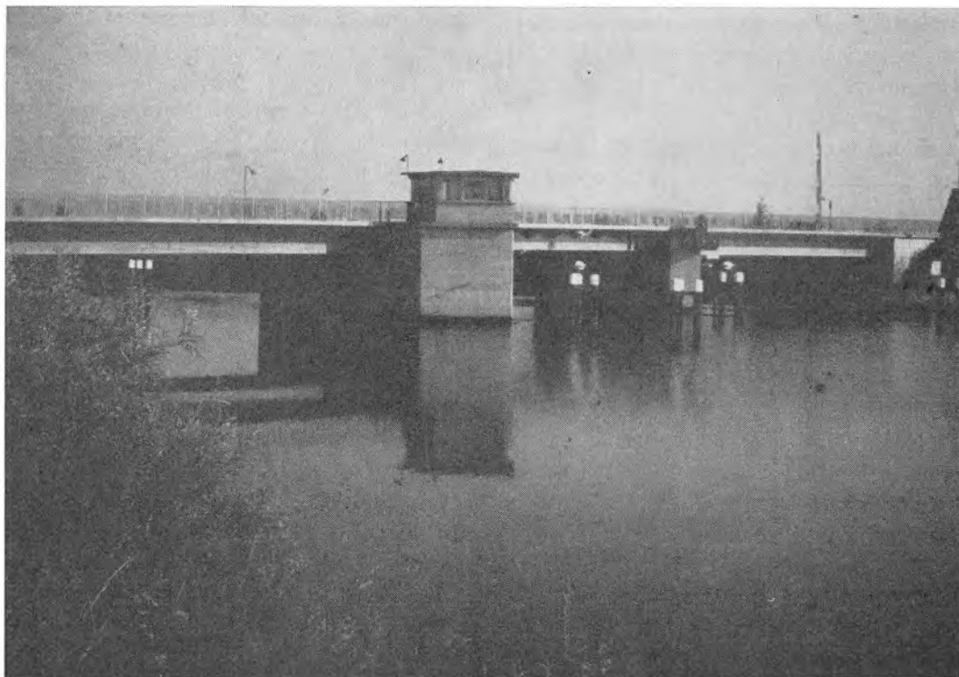
Den nye bro ved Palhude – Peterums »spøgelsesbro«.
