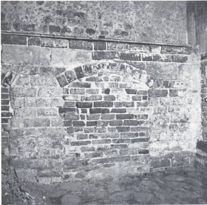
I kælderen til Stengade 64 blev der i forbindelse med restaureringen afdækket fire fladbuede vinduesåbninger i østmuren. Her ses den sydligste af disse. Nederst i billedet ses den yngre stenlægning og i højde med buestikket en del kalksten. Fot. 1976.
