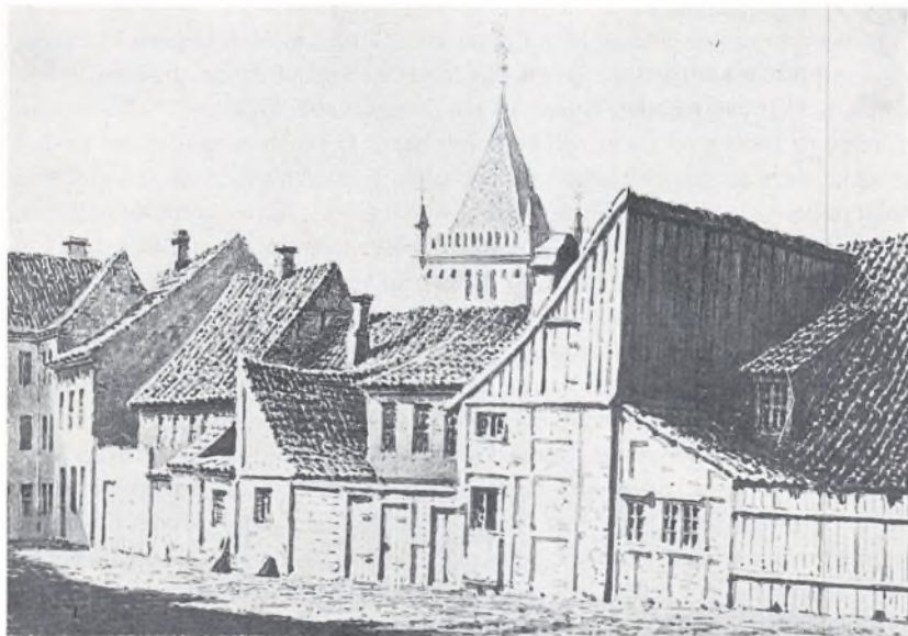
Bagfacaderne af de gamle slagterboder i Sct. Annagade. Hovedparten af boderne, der lå foran Sct. Olai kirke, er nedrevet i dette århundrede. Fotografi efter tegning af Chr. Hensch.
