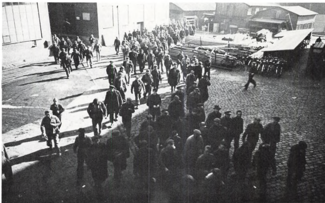
Arbejderne forlader Helsingør Værft den 24. august 1943 umiddelbart efter bombeeksplosionen på »Danzig«
