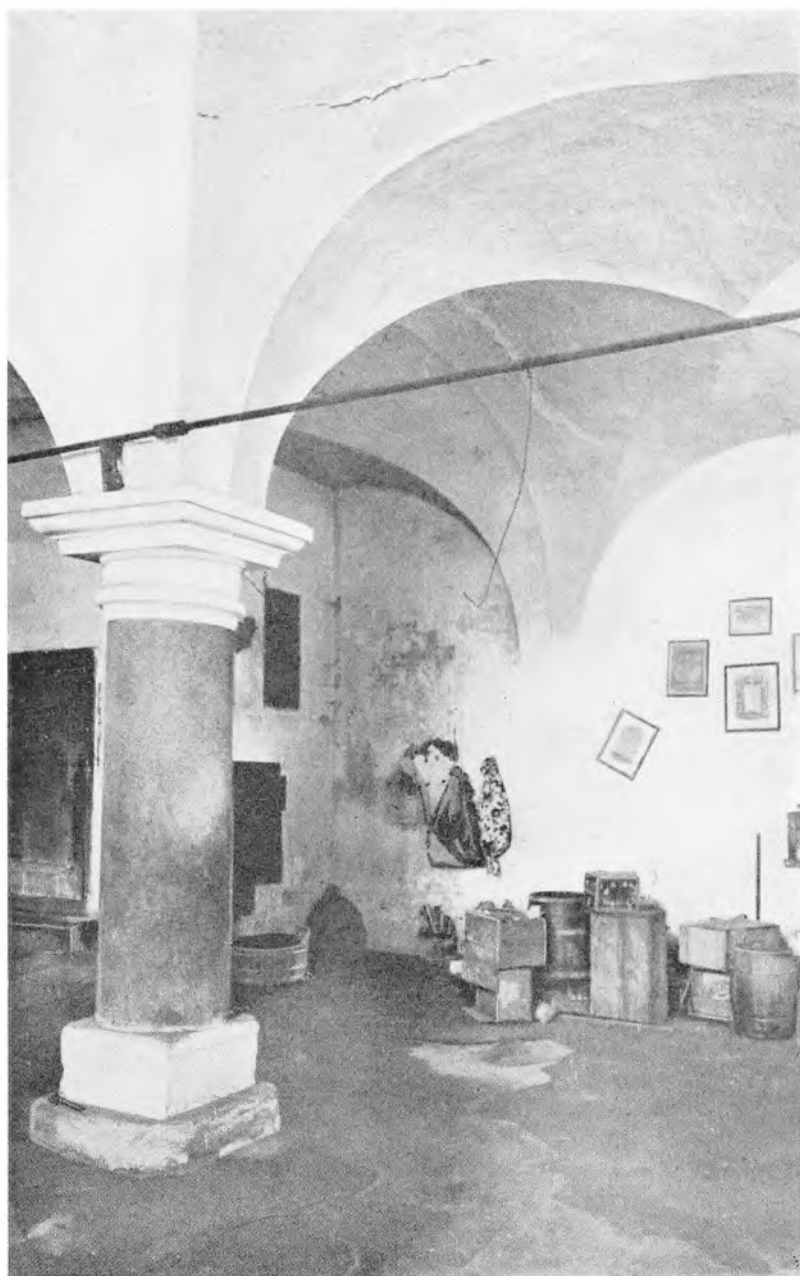
Interieur fra Slægtsgaarden „Urup“, visende de hundreaarige, endnu velbevarede, af massive Granitsøjler baarne Hvælvinger i den nordlige Hovedfløjs Kælder.
