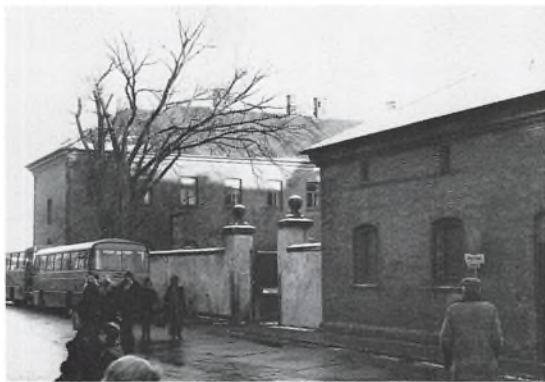
Muren mod Strandgade med det gamle elmetræ i baggrunden fotograferet i november 1976, da årets første sne var faldet. Helsingør Kommunes saneringsafdeling fot.
