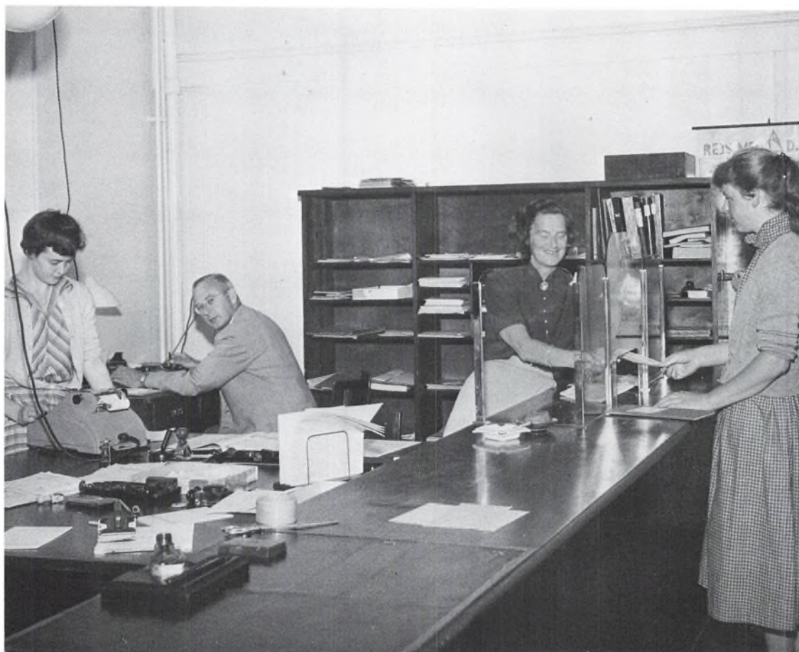
Ekspeditionslokalet i kontorbygningen fotograferet omkring 1952. Told- og Skatteregion Helsingør.
