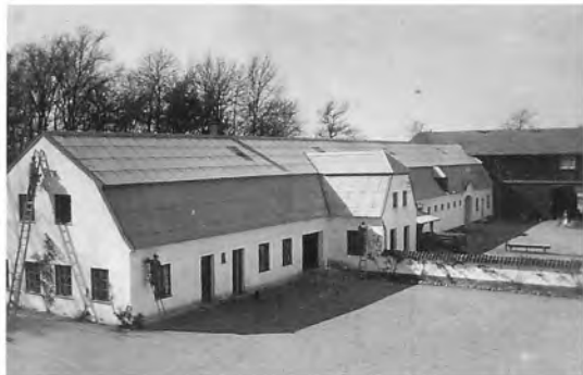
Elevfløjen kalkes i 1938.
