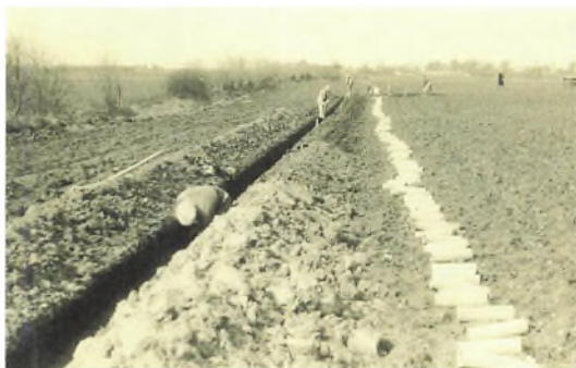
Der nedgraves tegl-drænrør i 1944.
