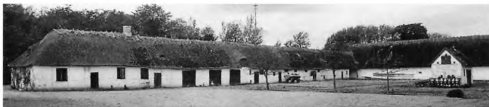
Bemærk at stald- og ladebygningerne i gamle dage havde stråtag. De blev i 1908 erstattet med eternittage.
