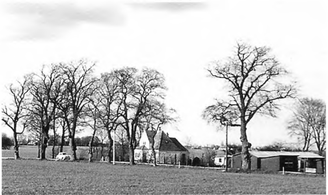
Fodermesterhuset i 1958. Til højre ses garage og hønse- og andehus.
