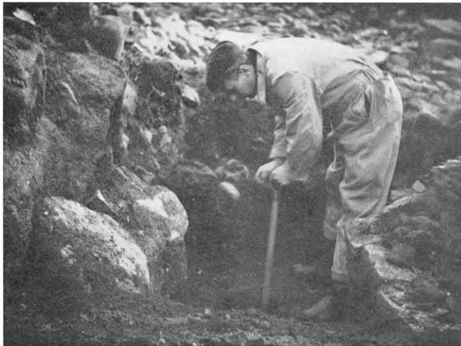
Montør Schou afdækker muren på sydsiden. Er det mon her tårnet stod? Til højre ses de fire munkesten, der tydeligt danner en runding.
