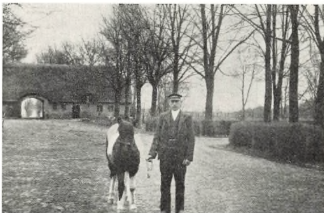
Gårdspladsen på Rask med den østlige længe og indkørslen til højre til hovedbygningen. Gennem porten udkørsel til »Fruens Vejs«.
