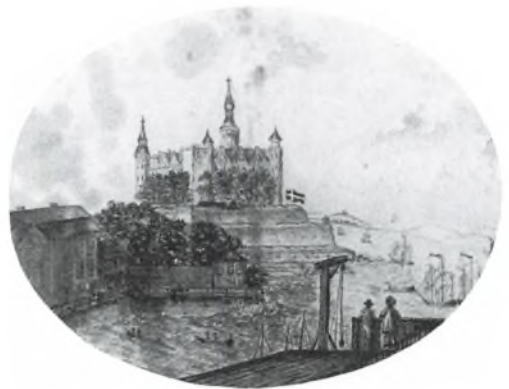
Kran på skibbro.
