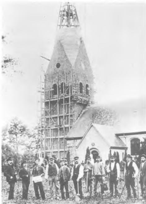
Kirketårnet under opførelse i oktober 1905. Foran ses sognepræst Th. Clausen og håndværkerne. Foto: Bov Museum.
