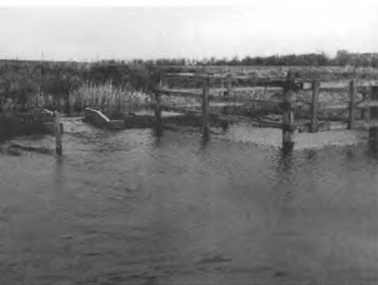
Fole engvanding er et overrislingssystem, hvor vandet dels skal tilføre området fugtighed, dels tilfører det næringssalte (gødevanding). Udsigt mod en af tudene der viser, hvorledes vandet føres fra hovedkanalen ud over engen. Foto: Vandløbsafdelingen. Sønderjyllands amt.
