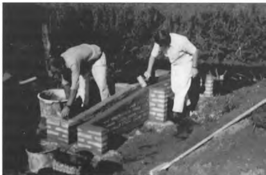
Murere i gang med opførelse af en tud. Foto: Vandløbsafdelingen. Sønderjyllands amt.
