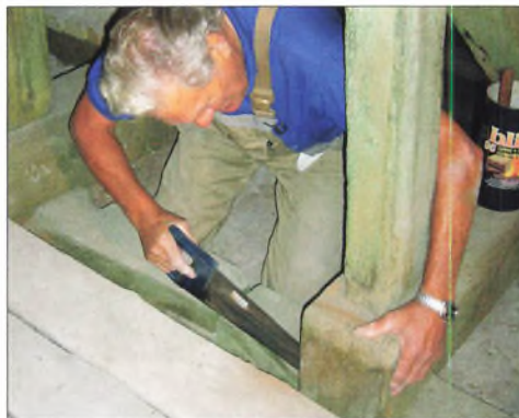
Tømrermester og kirkeværgen Arne Andersen i færd med at save en skive af en loftsbjælke på Mårslet Kirkes loft.
