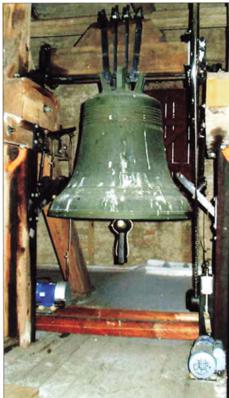
Ødum Kirkes klokke er fra 1637, men er omstøbt i 1914. Klokken blev automatiseret i 2001, og tovet blev udskiftet med automatik.
