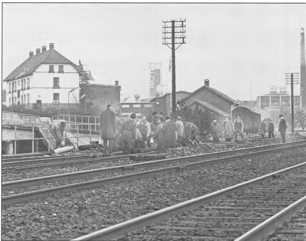
Sporene på Odderbanen er blevet vedligeholdt gennem mange år. Her er Odderbanens personale assisteret af personale fra DSB i gang med sporarbejde på Viby J station i 1972. Foto: Georg Schmidt.
