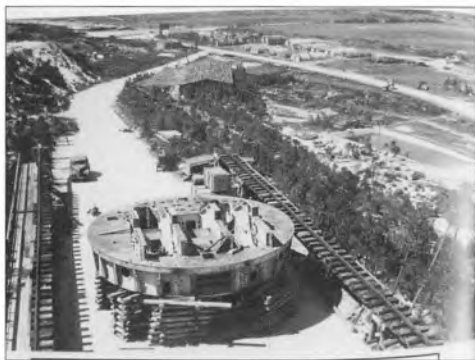
Kanonstillingen "Tirpitz" i Blåvand under bygning. Blev aldrig færdigbygget. (Foto fra Ingelise Helgesens bog: Hvad krukken gemte).
