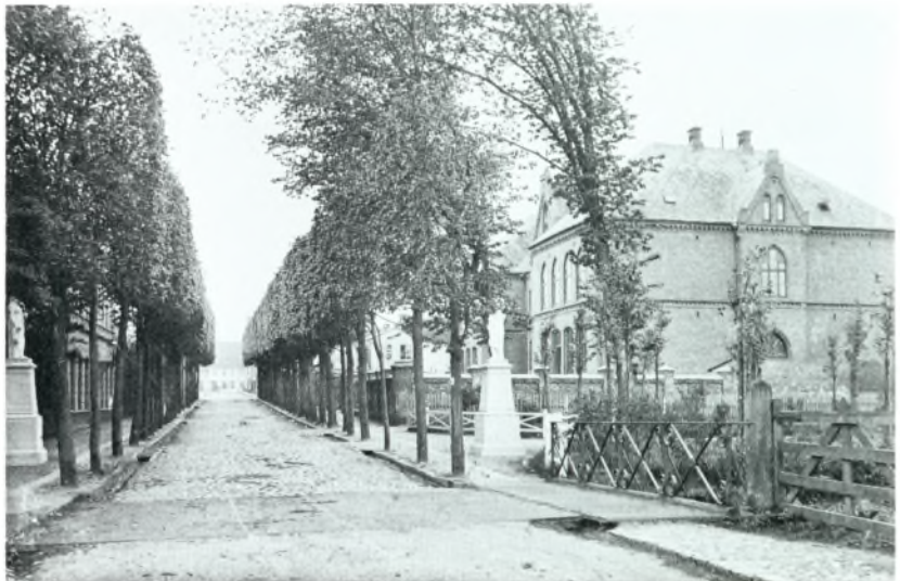
Richtsensgade med træbroen over Laurentiusstrømmen.
