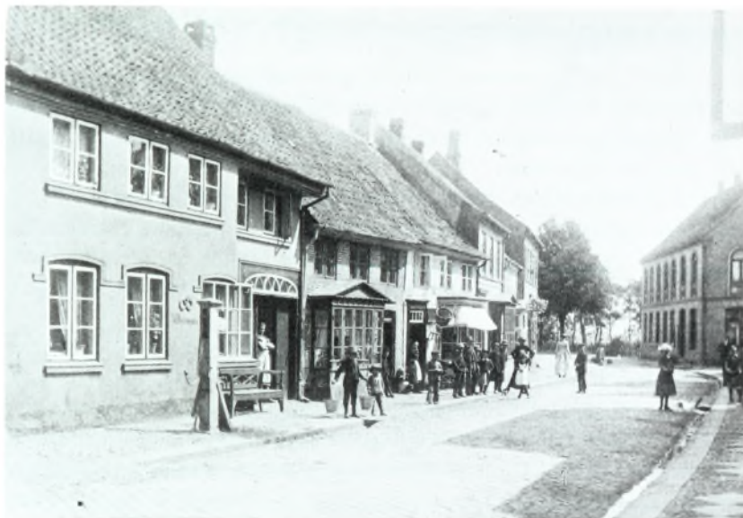
Pumpen i Søndergade.
