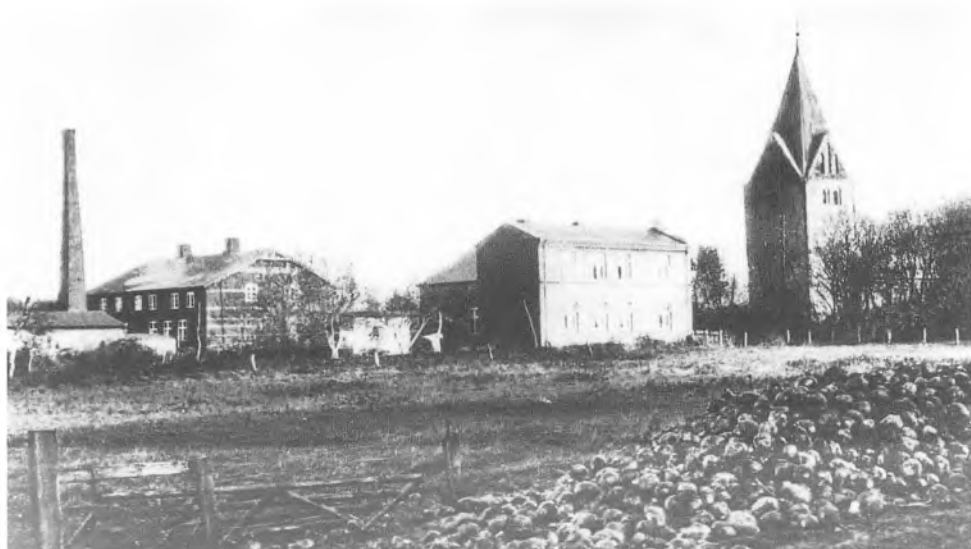
Skærbæk uldspinderi set fra sydvest, beliggende tæt ved Skærbæk kirke. Bemærk den meget høje skorsten ved spinderiet. Skorstenen anvendtes ikke kun af spinderiet, men også af dampelværket,
