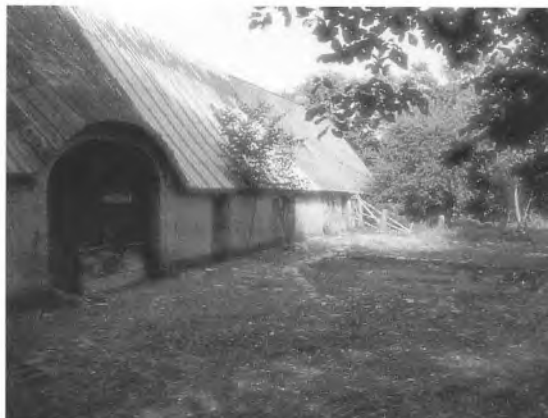
Sydsiden af anlægget med afstivning af stuehusets vakkelvorne ydervæg. Foto: Hanne Christensen 1997.
