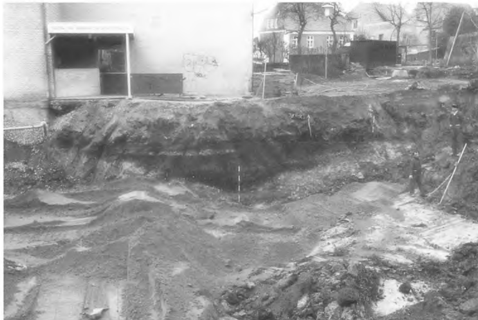
Den store voldgrav tegner sig i den stive lerjord i forbindelse med et byggeri langs Sct. Nicolai Gade. Foto: Lennart S. Madsen, Haderslev Museum.
