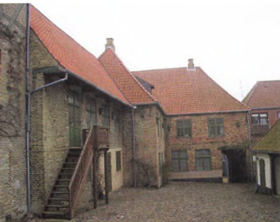
Et blik fra hovedbygningen mod bagsiden af forhuset, opført i røde og gule flensborgsten, samt porten ud mod Storegade. Foto: Institut for Sønderjysk Lokalhistorie.
