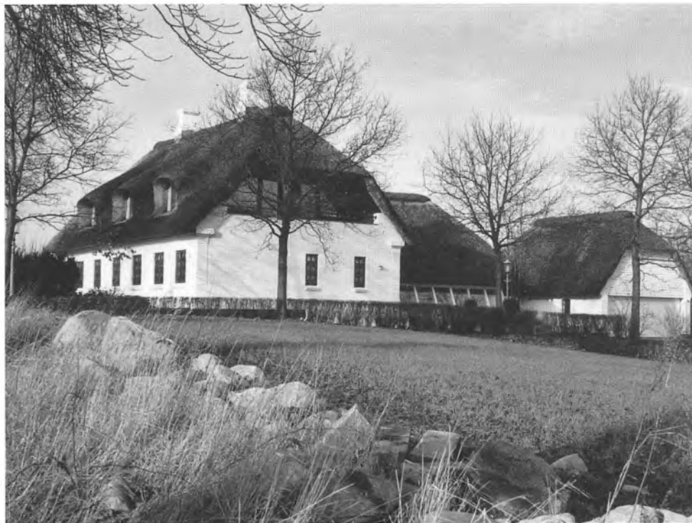
Efter toldvæsenets overtagelse af grænsebevogtningen i 1969 blev gendarmhusene solgt. Siden er to helt forsvundet, mens andre, som her i Bov, har undergået en markant forandring. Foto: N. P. Lund-Jensen.
