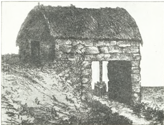
Gammel Vandmølle. Man ser Hjulet anbragt vandret i Strømmen.
