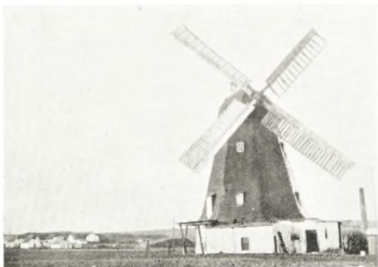
et Udtorringsareal. Marinus Madsen har to Gange været Ejer af Balle Mølle, idet han første Gang købte Møllen i 1910, men solgte den igen i 1913 til Møller Martin Ditlevsen. Denne lod i 1916 paasætte nyt Vindfang paa 32 Alen og forandrede Kludesejlene til Jalousi. I 1922 købtes Møllen af M. Bojstrup, og i 1923 købte den nuværende Ejer Møllen tilbage. I 1924 paasattes Selvkrojer og 4 nye Vingespidsler. I 1925 indlagdes ny 15 HK. Holstebro Petroleumsmotor. Sonnen, Hjalmar Ditlev Madsen, f. 20. Maj 1911, er oplært som Møller.
