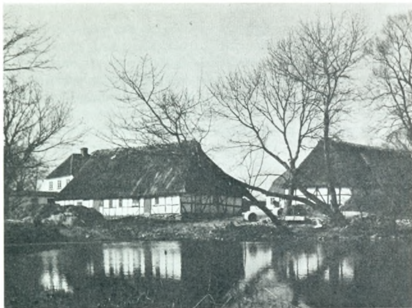
Kegnæs præstegård. Fot. ca. 1930 med de nu nedrevne stald- og ladebygninger.
