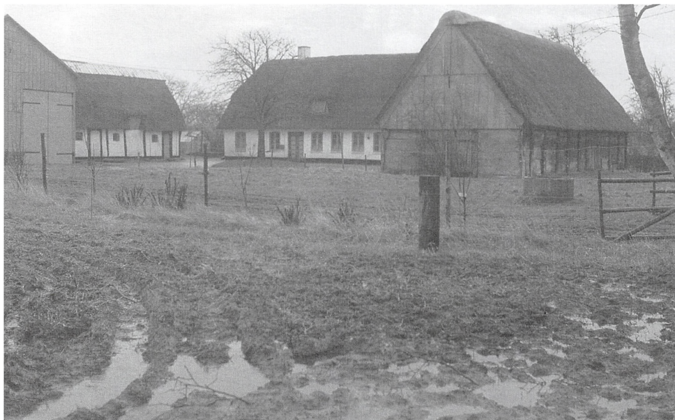
Bulhuset, Ørby nr. 20, set fra nordvest. Til højre ses den bedst bevarede ladebygning, til venstre den delvis bevarede og i midten det »nyere« stuehus. Foto: Jørgen Toft Jessen.
