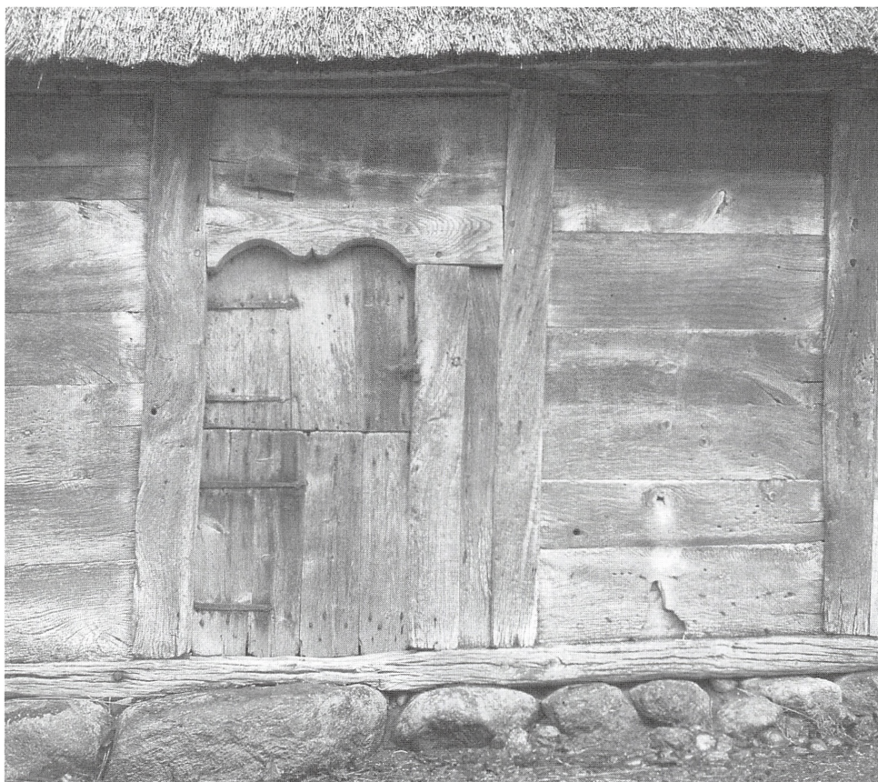
Smukt og typisk udsnit af bulkonstruktion med dør på Tyrstrup præstegårdslade. Foto: Jørgen Toft Jessen.
