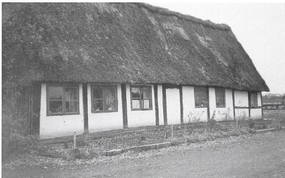
Den tidligere bulkonstruktion afslører sig gennem taghældningen og fagbredden, som her på dette billede af bulhuset i Flovt bygade. Foto: Jørgen Toft Jessen.
