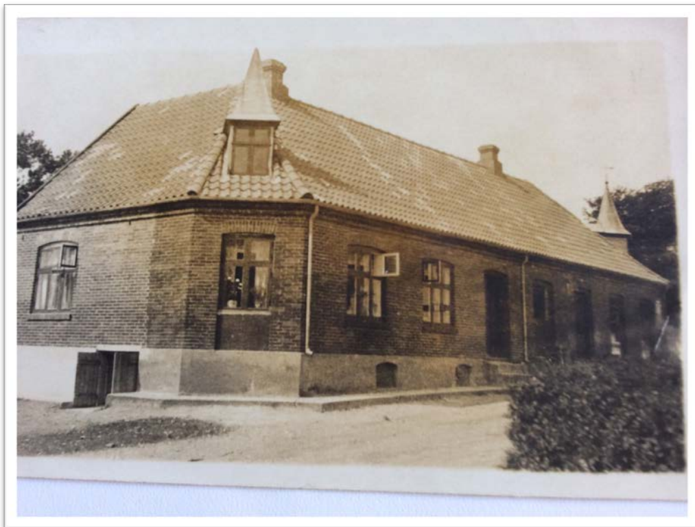
Skolegade 2 samt forretningsvinduer mod Skolegade.
