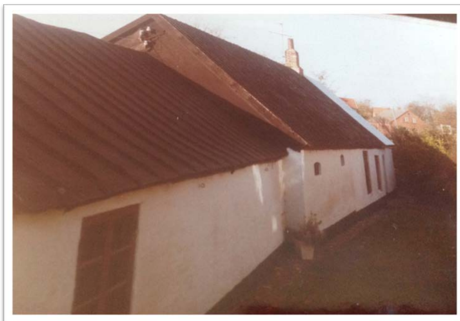
Baghuset fra gården. F.v. : vindue til vaskehus, tilmurede lokummer, stalden og lejligheden til slut.
