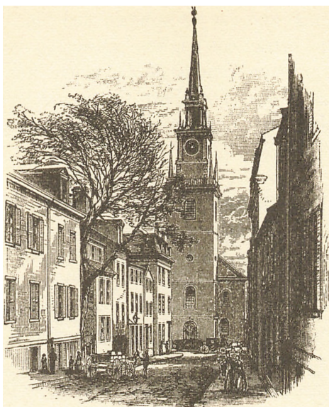
Old North Church, der spillede en rolle som »signaltårn« under frihedskampen mod englænderne i Boston.
