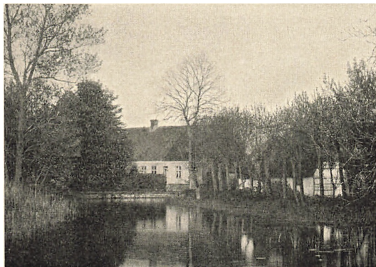
Have Mølle dam (tørlagt 1906)
