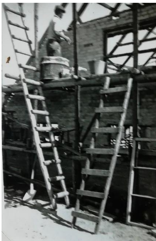
Byggeri af ny staldbygning i 1959
