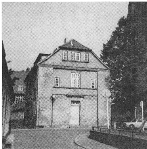
Süderdomstrasse 4, der ligger skråt over den Hattenske Gård, ligger vest for domkirken. Bygningen er den i 1842 opførte Vajsensskole. Foto: Børge L. Barløse, juli 1975.
