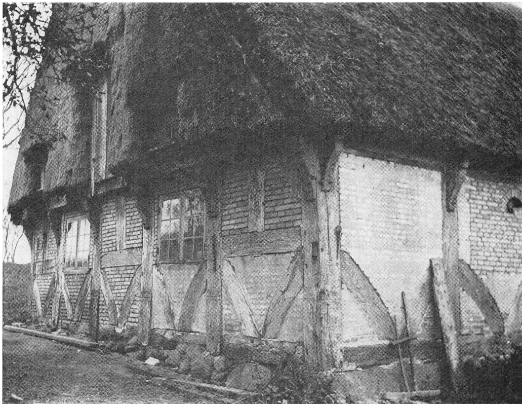
Knægtbygget gavlf af stuehus i Genner, Øster Løgum sogn, opført 1638. Vinduerne i de to kløver i østgavlen er fornyet og gjort højere ved at skære løsholterne ud. Stolperne i gavlen er forsynet med en skæl-fod, der griber ned over fodremmen. Gavlen har næppe oprindelig været stråklædt. Fra denne længe stammer Flensborg-museets panelstue (Mogens Clemmesen fot. 1910).
