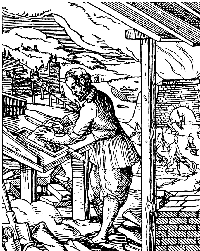
Træsnit fra 1568. Teglstrygeren ælter ler til en tagsten. I baggrunden ses byggepladsen og en ovn til brænding af stenene.
