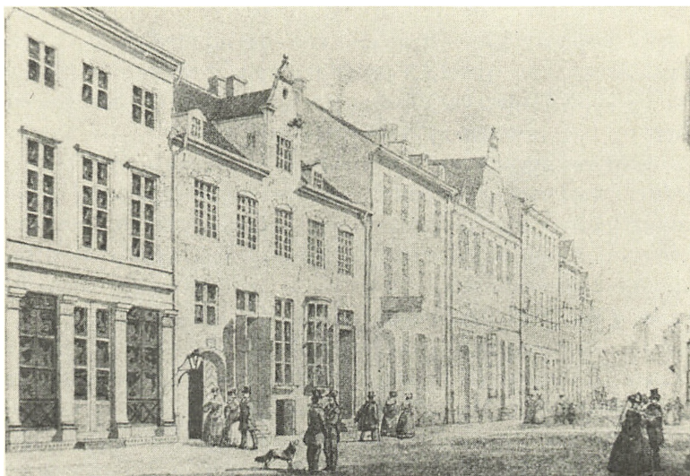
Østergade set mod øst omkring 1840. I forgrunden det kort forinden ombyggede Kong Salomons apotek (nr. 58 A), herefter følger Østergade 58, som var opført omkring 1640–45. Efter tegning gengivet i E. Dam: Kong Salomons Apotek, 1908.
