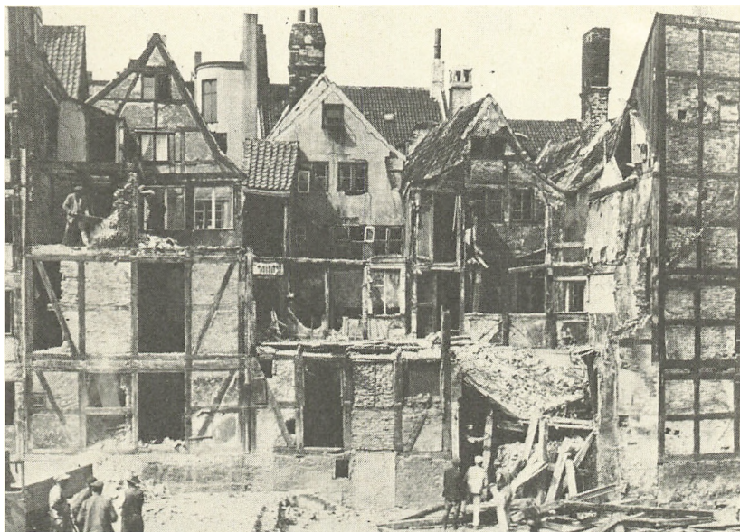
Lille Kongensgade 23–29 set bagfra under nedrivningen 1932. Bag de halvvejs nedrevne baghuse ser man tydeligt gavlhusenes gårdsider. Københavns Bymuseum.
