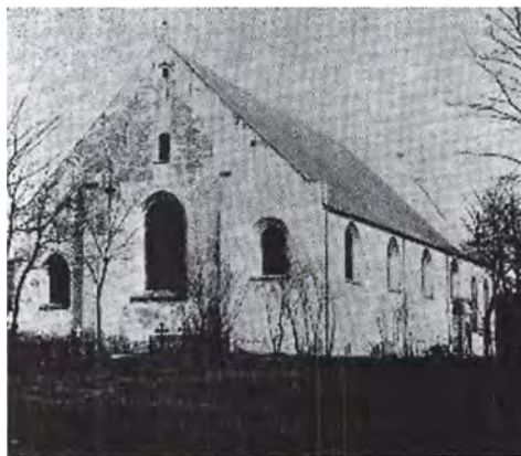
Klosterkirken før restaureringen i 1890-erne.
