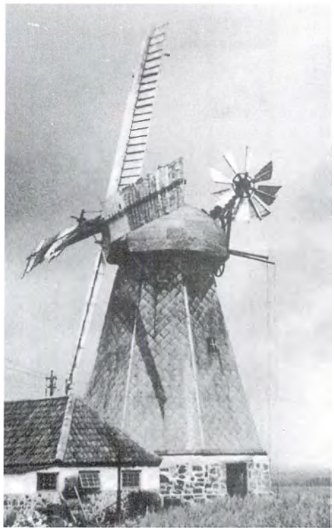
Alrø mølle 1934 da vingerne var selvsvik-kende og hatten selvkrøjende. I huset ved siden af var det en 25 Hk Deutz- og en 30 Hk Modaa-g-motor som bl.a. forsynede øen med strøm. (Foto udlånt af Odder Lokalhistoriske Arkiv).
