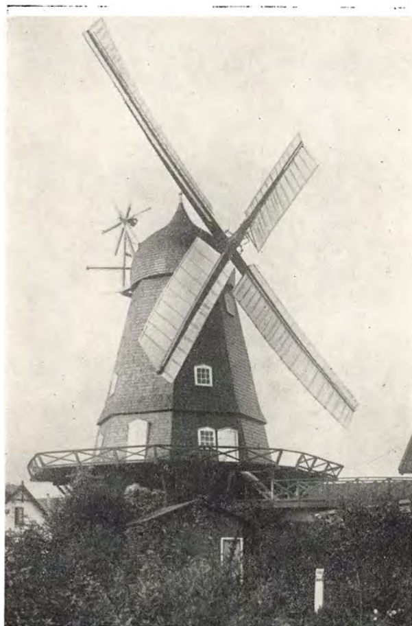
Møllen ved Bageriet. Aage Remfeldts fot.
