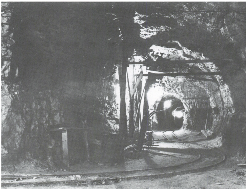
Fig. 3. Billede fra opførelse af tunnelparti taget den 16. februar 1966. Fotografering af det hemmelige anlæg var næppe tilladt, men alligevel findes der en række fotos fra opførelsen af anlægget.
