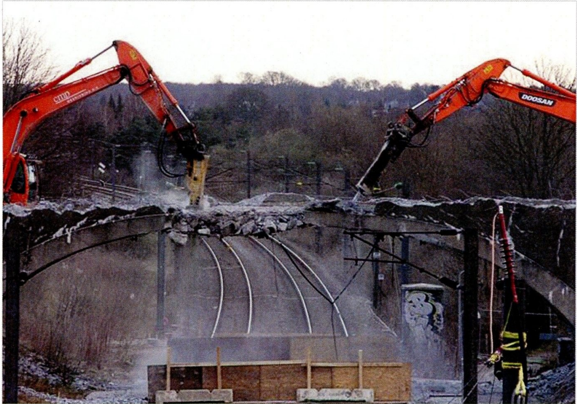
Nedrivning af Lågegydebroen , marts 2012, fot. Morten Timm, Ugebladet Hørsholm
