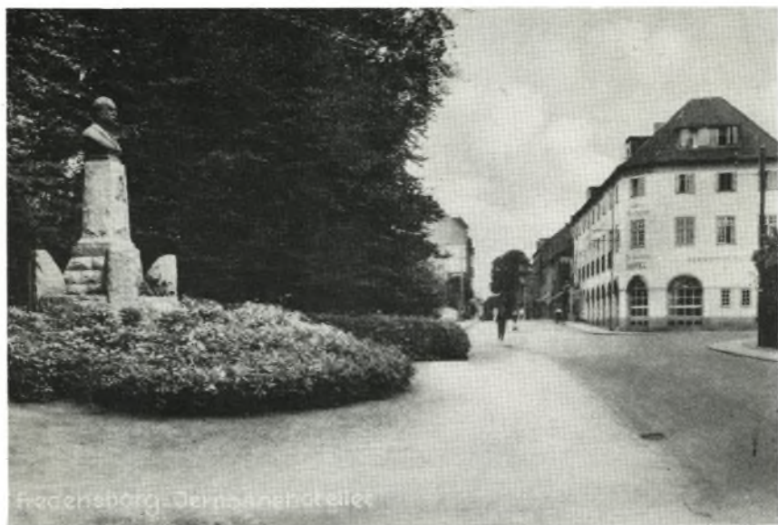
Jernbanehotellet 1930 set fra Lunden. Bygningen er opført efter branden 1919.
