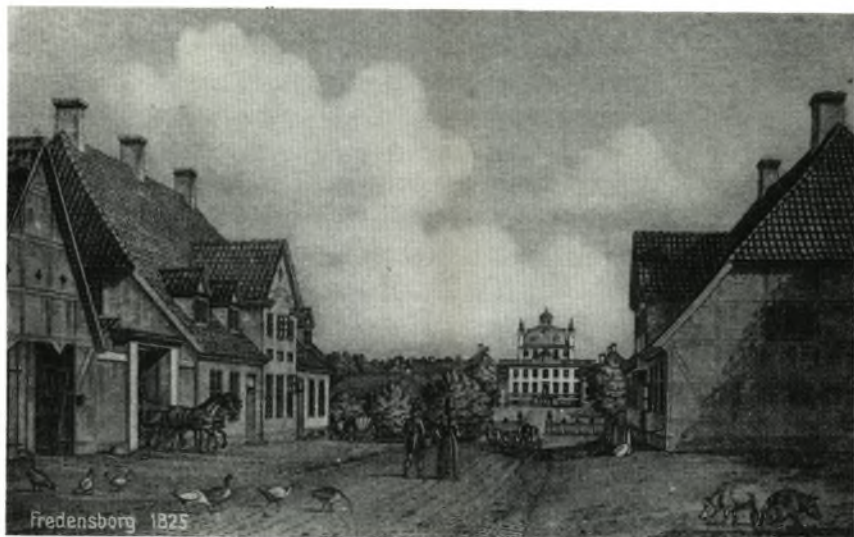
Slotsgade med Store Kro i venstre side. Bygningen i højre side er »Lille Kro«, oprindelig rejsestald. Billedet er fra 1825 og er det ældste billede af kroen.
