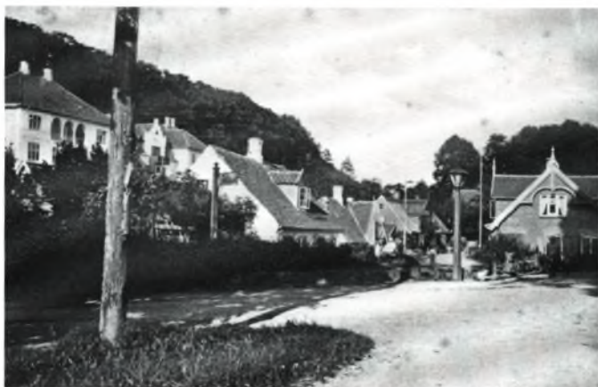
Fredensborg, Dalen, husene på skrænten brænder i 1904. Det er de nyopførte huse der ses, så billedet er fra omkring 1907 (LHA)
