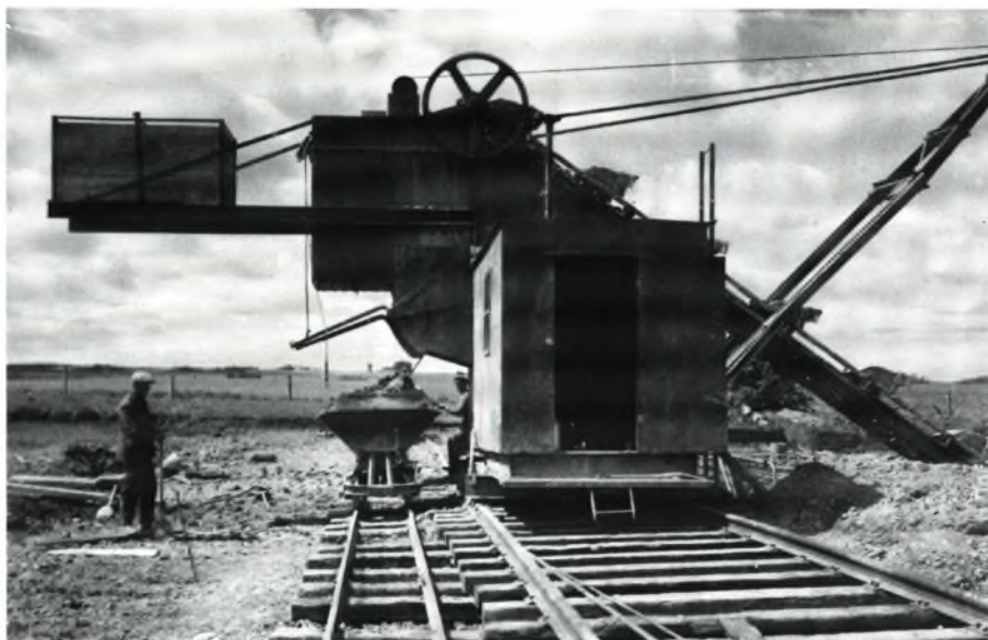
Gravemaskine og arbejdsskur i lergraven ved Kongevejen. C.L. 1936.
